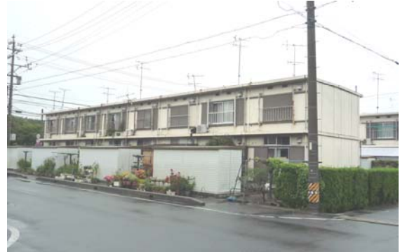
○簡易耐火住宅（2階建、6棟、42戸）
