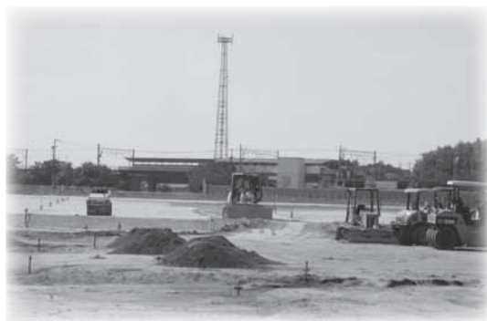
造成工事は 間もなく完了 撮影：令和元年9月
