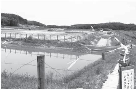
造成工事中の治水対策として整備された「仮設」の調整池
