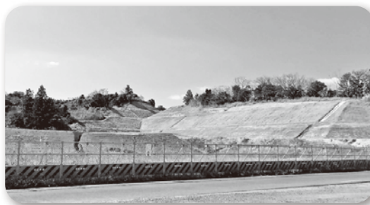
総合公園拡張事業建設現場
