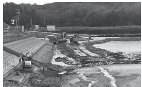
耐震工事中の北方・吉田池
