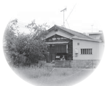
取り壊し予定の町営住宅
