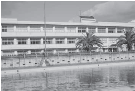
河和中学校のプール
