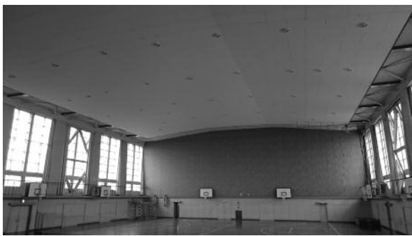
体育館吊天井を落下防止工事（野間中学校）
