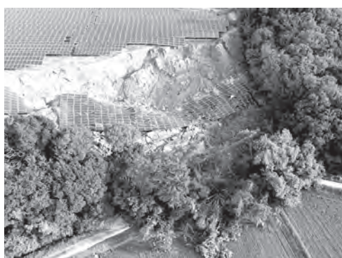
太陽光発電施設の崩落
