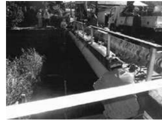
杉代水管橋架替工事
