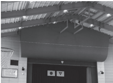
布土小体育館
