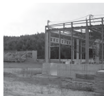
陸上競技場工事の様子
