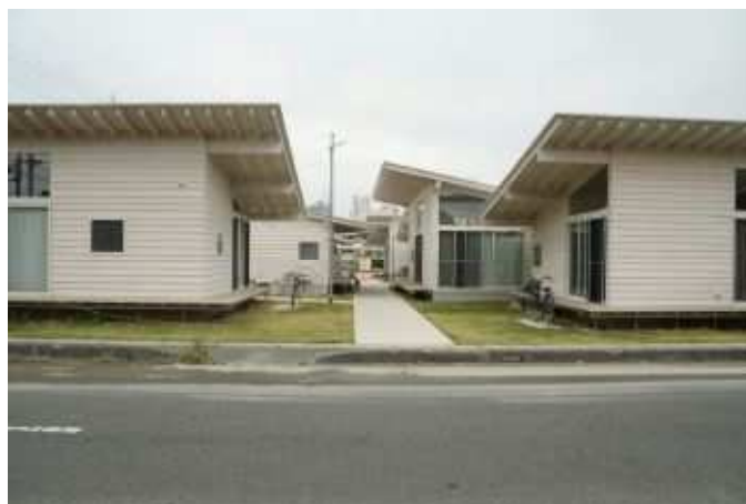
写真：町営住宅（河和第二団地）
