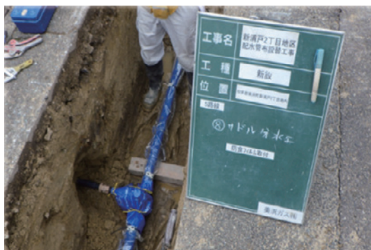
新浦戸地区配水管布設替工事 7,053万円
