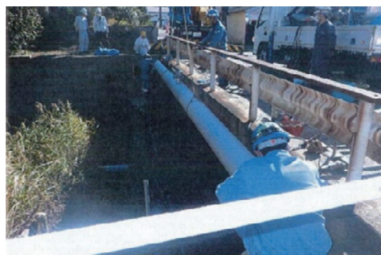
杉代橋水管橋架設工事 587万円
