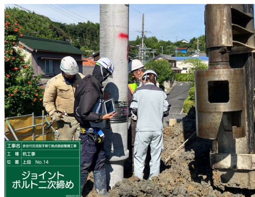
7 月 杭設置工事
