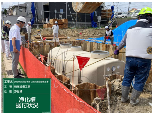
6 月 浄化槽設置工事
