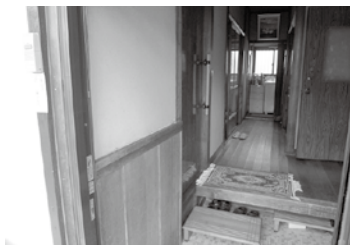
▲ 手すり取付前
