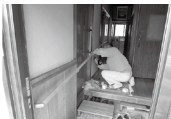
▲ 手すり取付後
