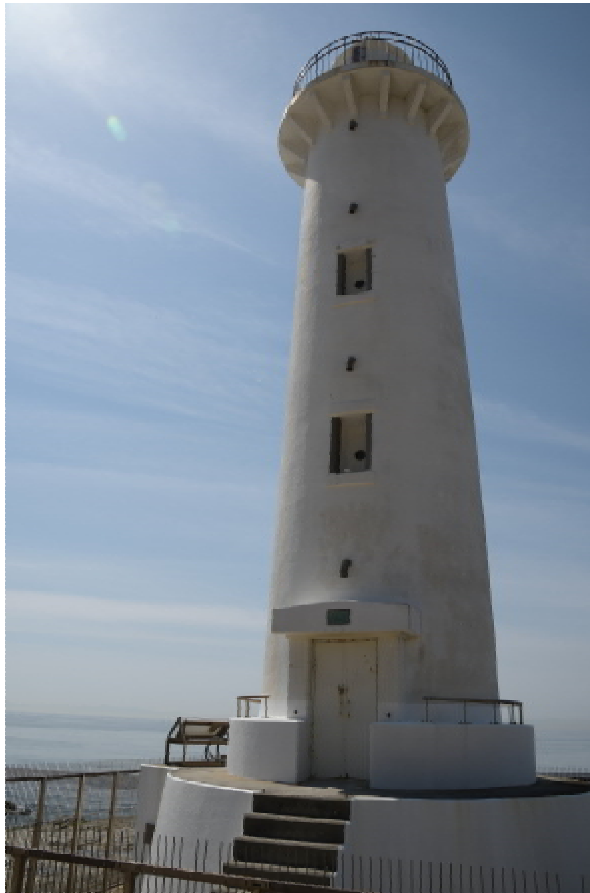
写真：野間埼灯台
