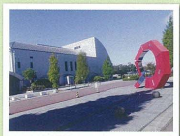
1 総合公園体育館
